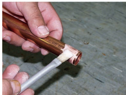
4. Flussmittel am Rohr auftragen
