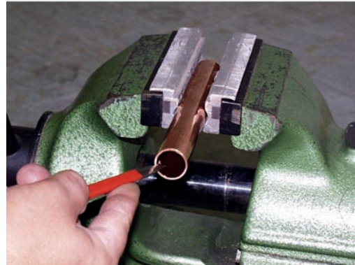
2. Rohr innen und außen entgraten
