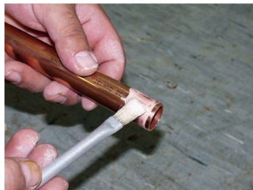
4. Flussmittel am Rohr auftragen
