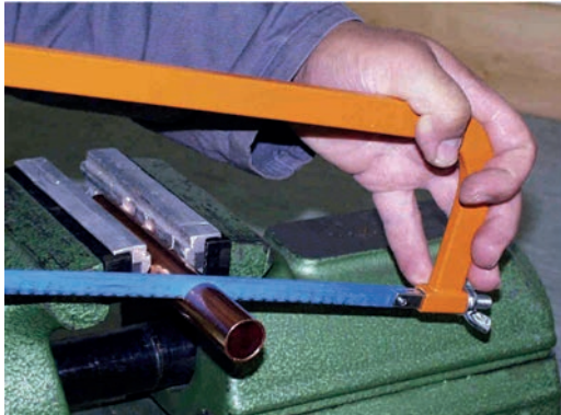
1. Rohre rechtwinklig absägen
